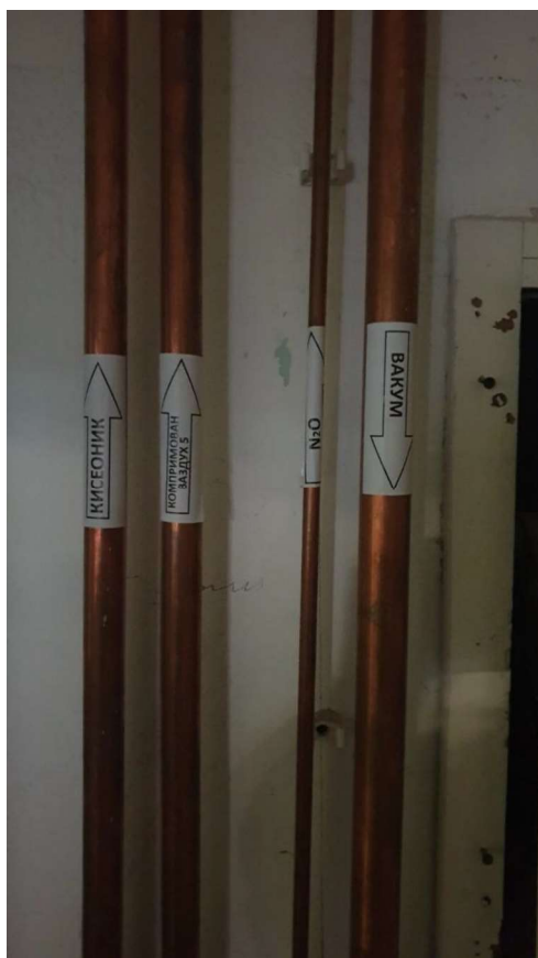
Primer rasporeda cijevi i obilježavanje
