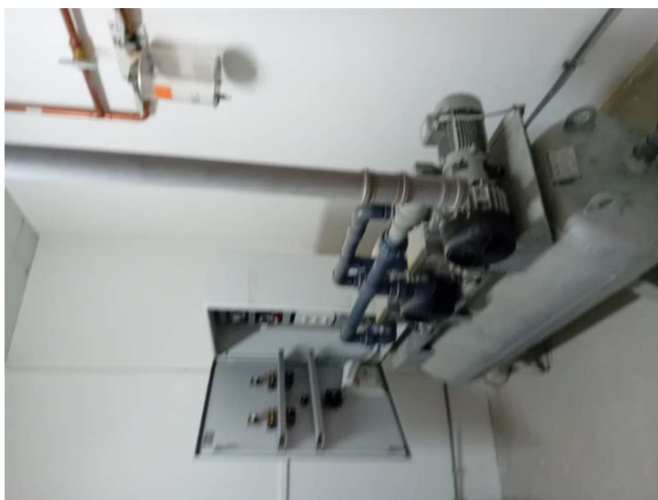
Primjer duples vakum agregata sa 2 rotacione vakum pumpe.
